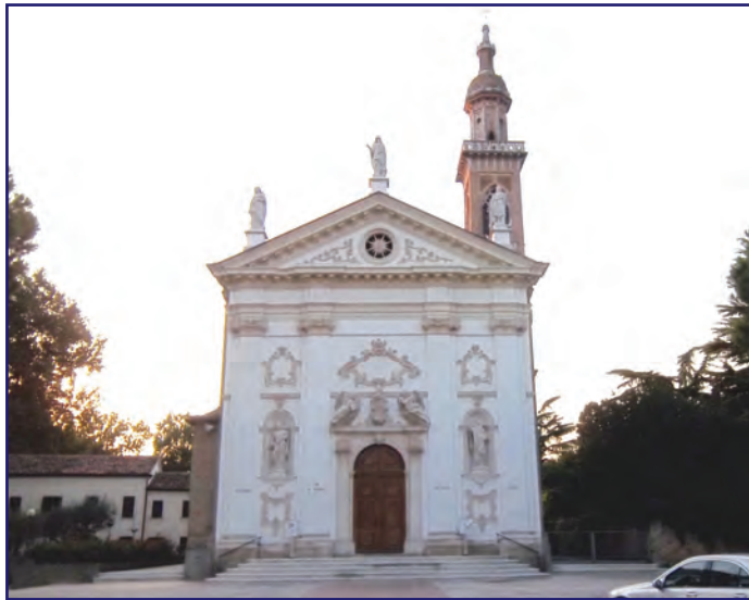
La facciata della Chiesa di Noventa Padovana dopo il restauro
